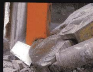
■H400 x 400角柱穴あけ切断
